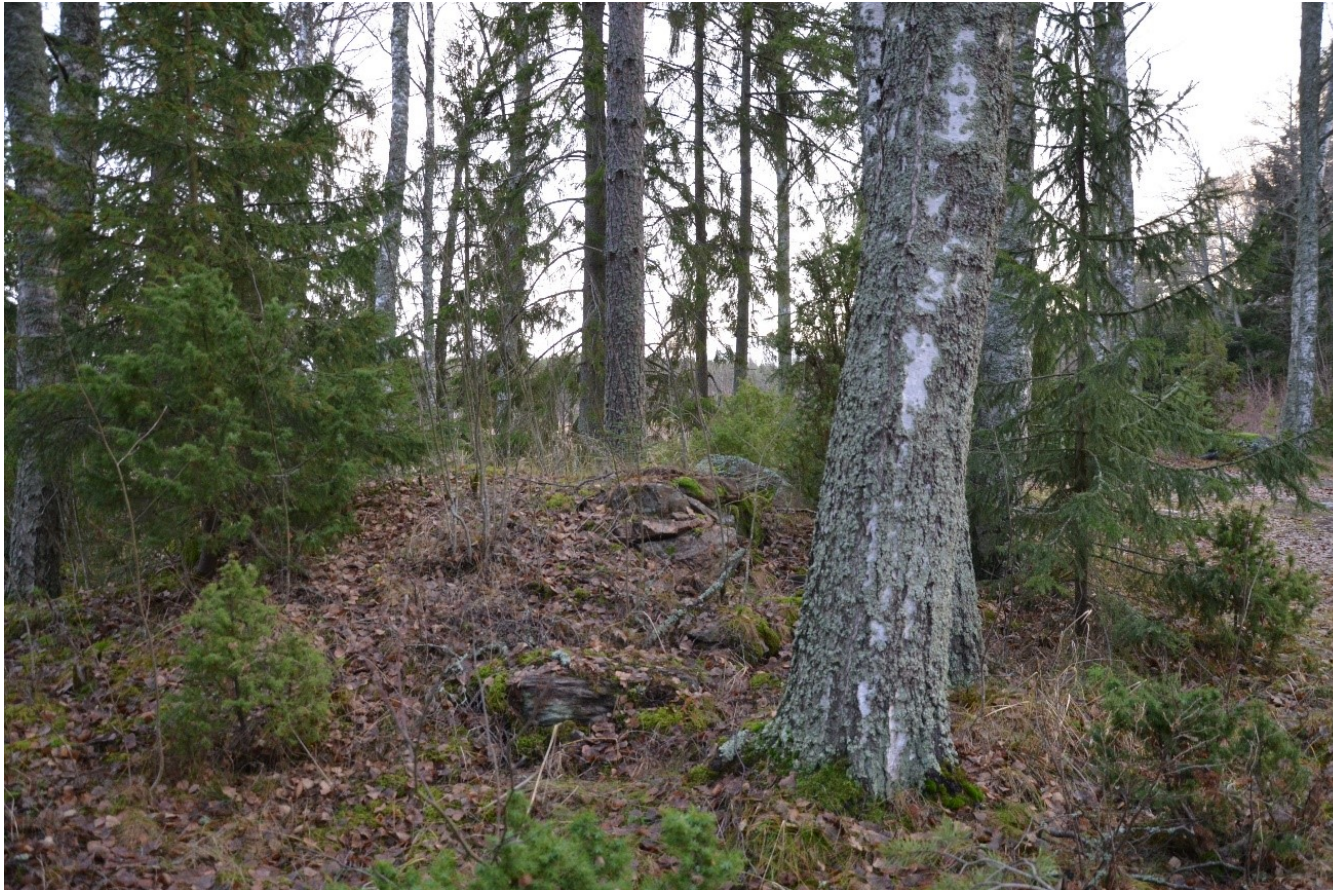
Kuva: Laivanrakennukseen liittyvän pajan perustus. pajasta on jäljellä luonnonkivistä rakennettu sokkeli.
